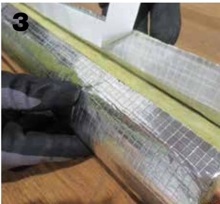
Der Längsschlitz kann nun über die werkseitig angebrachte Überlappung luftdicht verschlossen werden. Drücken Sie die Überlappung gut an, um eine zuverlässige Haftung zu erhalten.
