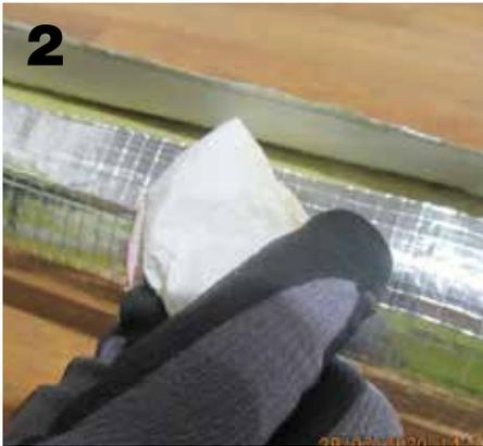
Bevor die Isolierung mittels der selbstklebenden ALU-Überlappung geschlossen werden kann, muss die Rohrschale passgenau zusammengedrückt werden. Achten Sie darauf, dass alle Klebeflächen trocken, sauber und fettfrei sind und reinigen Sie diese ggf. vor der Verklebung.
