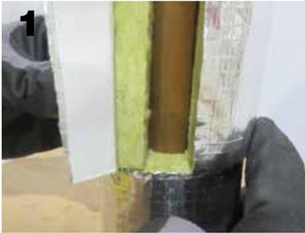
Die Steinwoll-Rohrschale mit Aluminiumkaschierung ist längs geschlitzt und lässt sich dadurch einfach aufklappen und um das zu dämmende Rohr legen.
