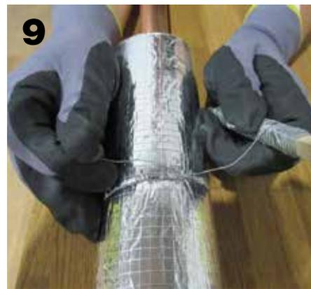
9 Es wird empfohlen, die Rohrschalen zusätzlich mit Aluminium-Band oder einem weichen, verzinkten Bindendraht zu befestigen<sup>2</sup>.
