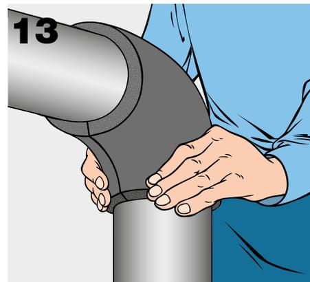
Nun können die Rundnähte mit der Schlauchisolierung verklebt werden.
