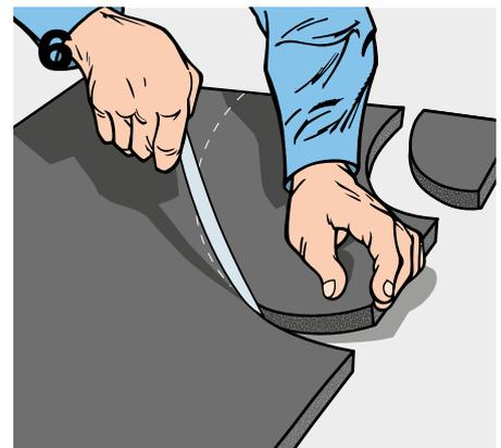
Mit Hilfe des ersten Halbkreises wird mit dem Silberstift der zweite Halbkreis auf einer weiteren Platte angezeichnet und ausgeschnitten.
