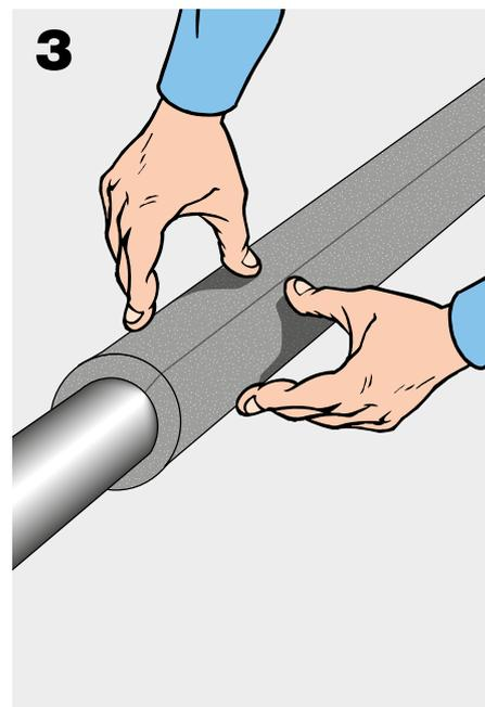
Öffnen Sie den K-FLEX® PE Schlauch und streichen Sie beide Schnittkanten mit K-FLEX® Kleber ein. Sobald der K-FLEX® Kleber keine Fäden mehr zieht (Fingerprobe), verschließen Sie den Schlauch mit kurzem, festem Druck. Verarbeiten Sie K-FLEX® PE niemals auf Zug.
